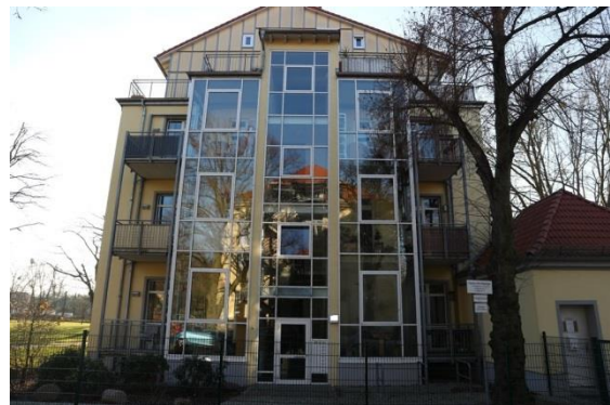
Foto 4: Giebelansicht des Hauses
