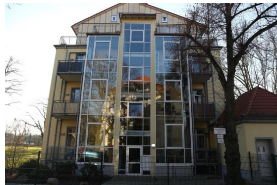
Foto 4: Giebelansicht des Hauses
